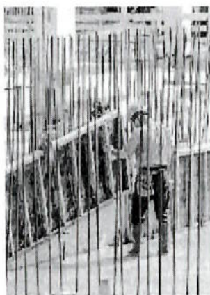
Un operaio in un cantiere
